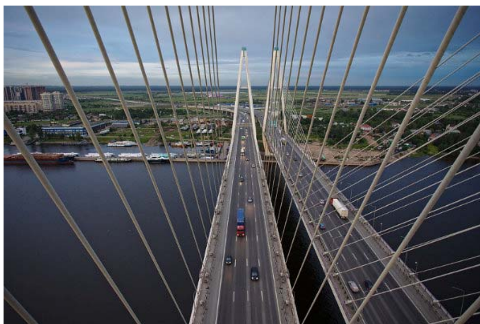
Рис. 44. Большой Обуховский мост
