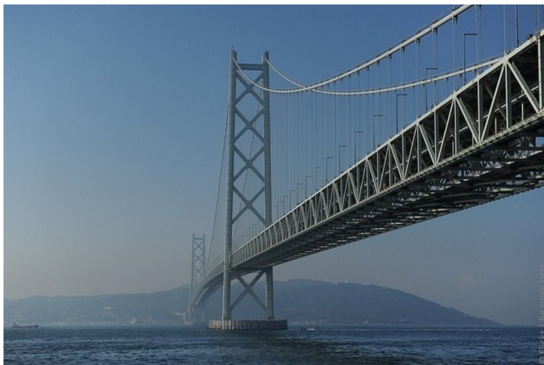
Рис. 32. Висячий автомобильный мост Акаси-Кайке
