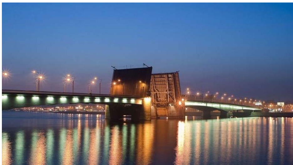
Рис. 46. Двукрылое разводное пролетное строение
