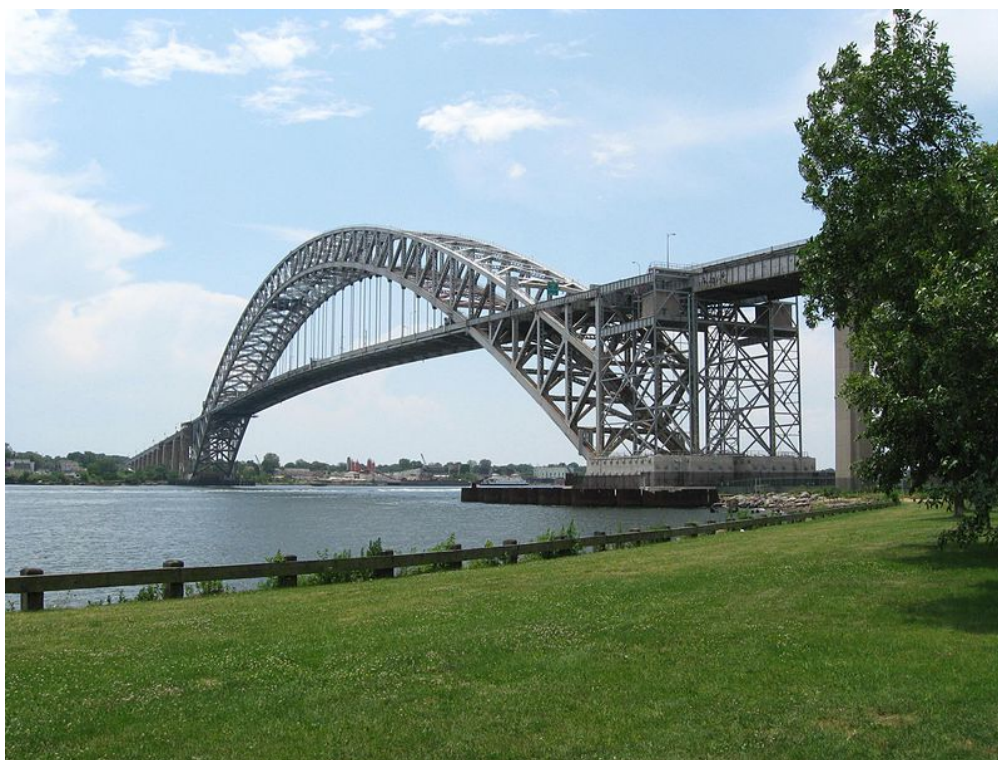
Рис. 20. Бейоннский мост через пролив Килл-ван-Килл в США
