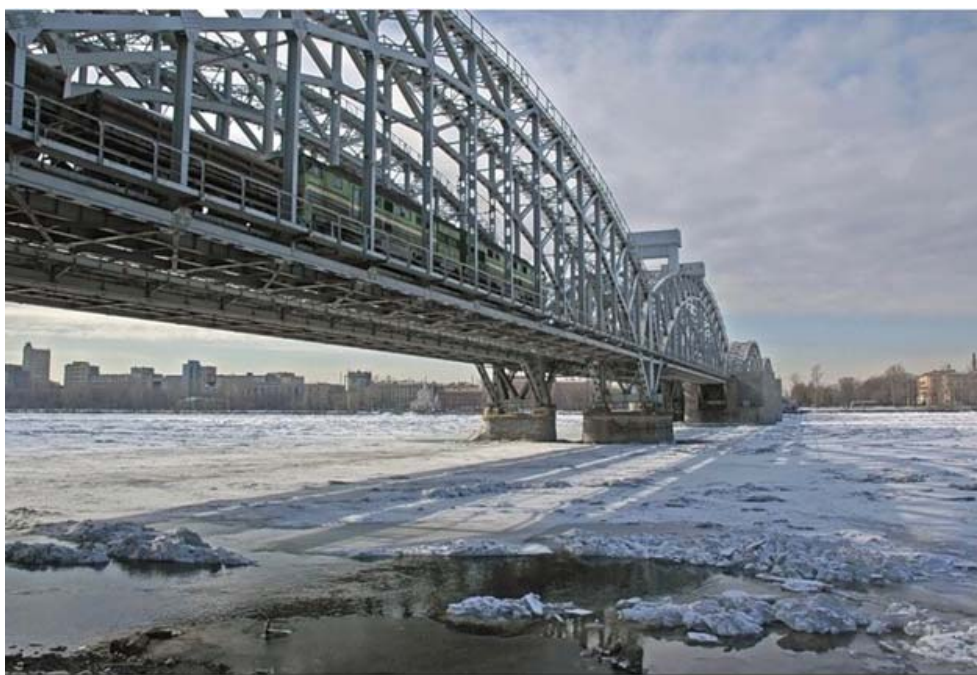
Рис. 53. Финляндский железнодорожный мост
