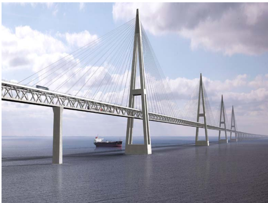
Рис. 93. Мост через пролив Фемарн-Бельт
