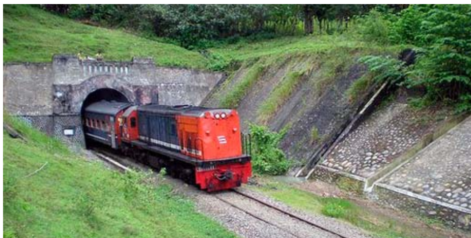
Рис. 100. Железнодорожный тоннель на линии Ливерпуль — Манчестер
