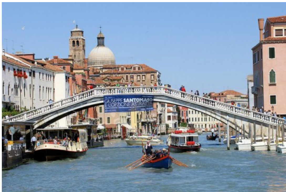
Рис. 84. Мост Скальци расположен рядом с железнодорожным вокзалом
