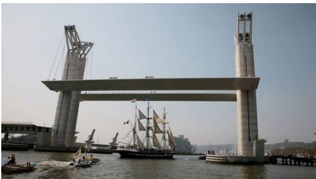
Рис. 39. Мост Гюстава Флобера в Руане, Франция
