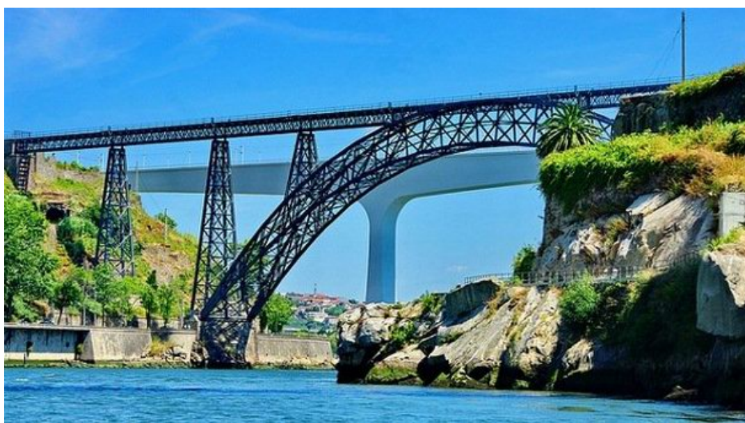
Рис. 16. Мост Понте-де-Дона-Мария-Пиа в Португалии
